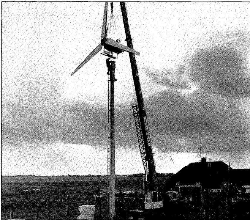
Het aanbrengen van de wieken
