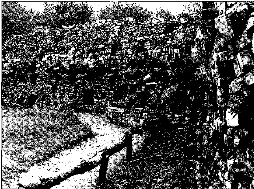
Bouwen de muur, heneden de kruidentuin
