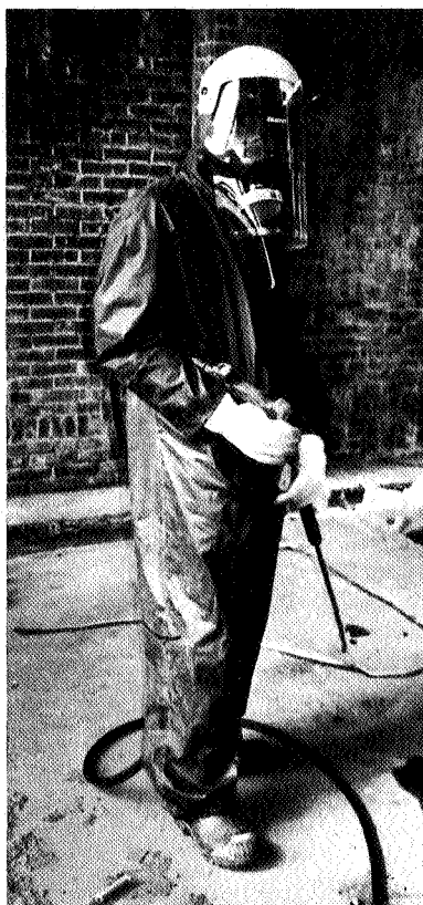
De gebouwen worden gereinigd met behulp van hoge druk spuiten
