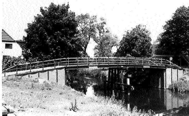
4. Hoog in de weg gelegen vaste balkbrug bij Wehe-Den Hoorn. Deze bruggen zijn kenmerkend voor het Groninger zeekeleigebied.
