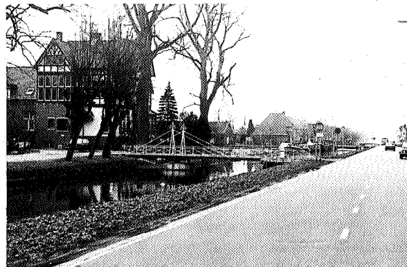
8. Draaibrug uitgevoerd met pylonen en trekstaven over het Oosterdiep in Veendam
