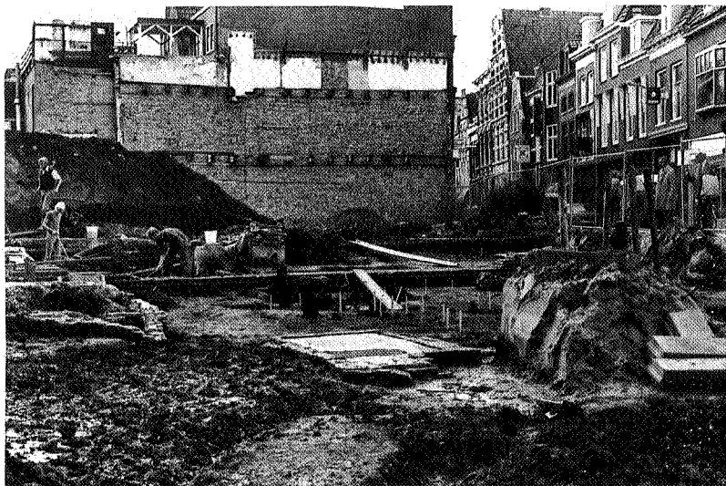
Afb. 1. De zojuist gestarte opgraving. Tussen de fundamenteën van de stenen huizen zijn de houten fundamenteën van laatmiddeleeuwse huizen zichtbaar geworden. De foto is genomen vanaf het Gouverneursplein met de blik op de St. Jacobsstraat.
