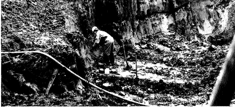
Sanering NS-terrein Groningen.
