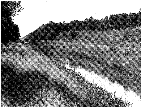
De 2-3 meter diepe ligging van de verlengde Noordersloot dwars door het Bargerveen leidt (nu nog) tot verdroging van dit reservaat
