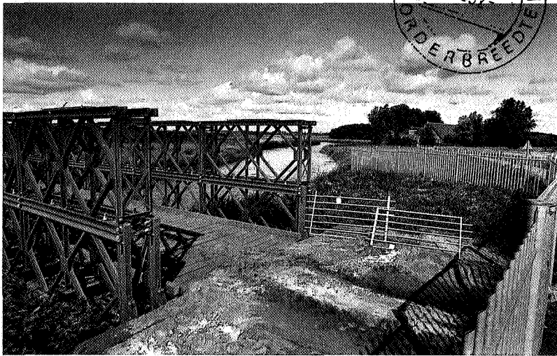
Aangelegde brug over het Peizerdiepje
