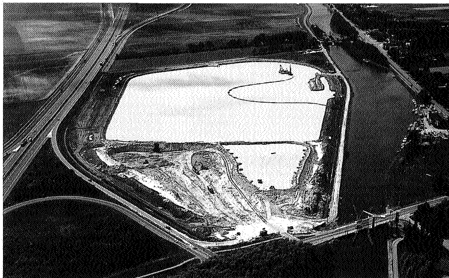
Het mengbekken op de achtergrond, op de voorgrond de beide zanddepots, opname oktober 1994, foto Aerophoto Eelde
