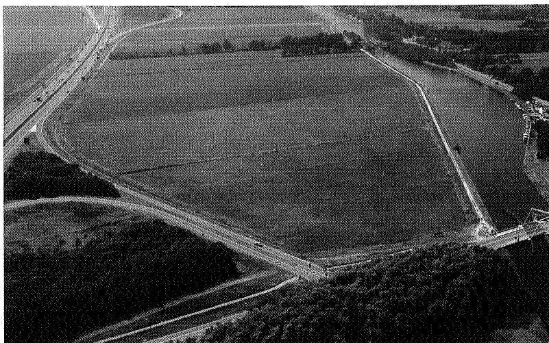
Lokatie van het mengbekken vóór de aanvang van de werkzaamheden, links de A-28, rechts het Noord-Willemskanaal, foto Aerophoto Eelde
