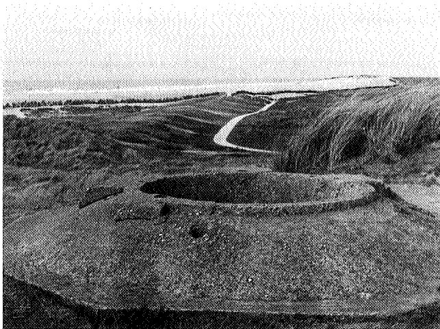
Betonnen geschutskoepel in de Oostbatterij, een zware luchtafweerstand bij Oosterend op Terschelling, ter hoogte van paal 19. Collectie Douwe de Groot.
