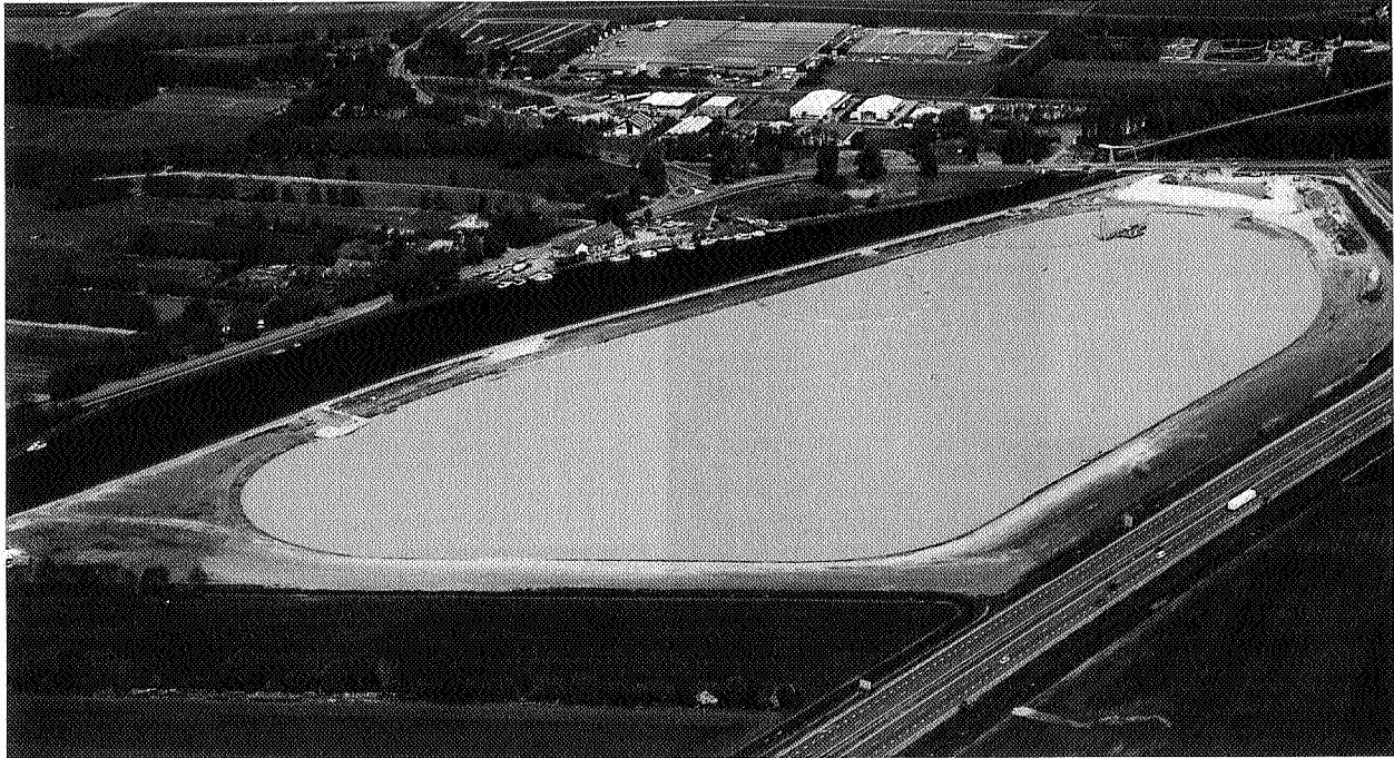
Het Gemeentelijk Waterbedrijf Groningen wil met behulp van het nieuwe mengbekken bij De Punt oppervlaktewater winnen, foto Aerophoto Eelde
