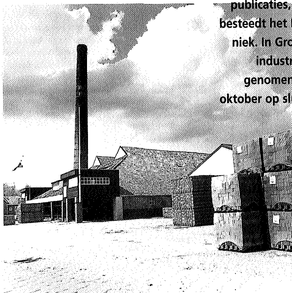
Steenfabriek Hijlkema te Delfzijl, foto Jur Bosboom
