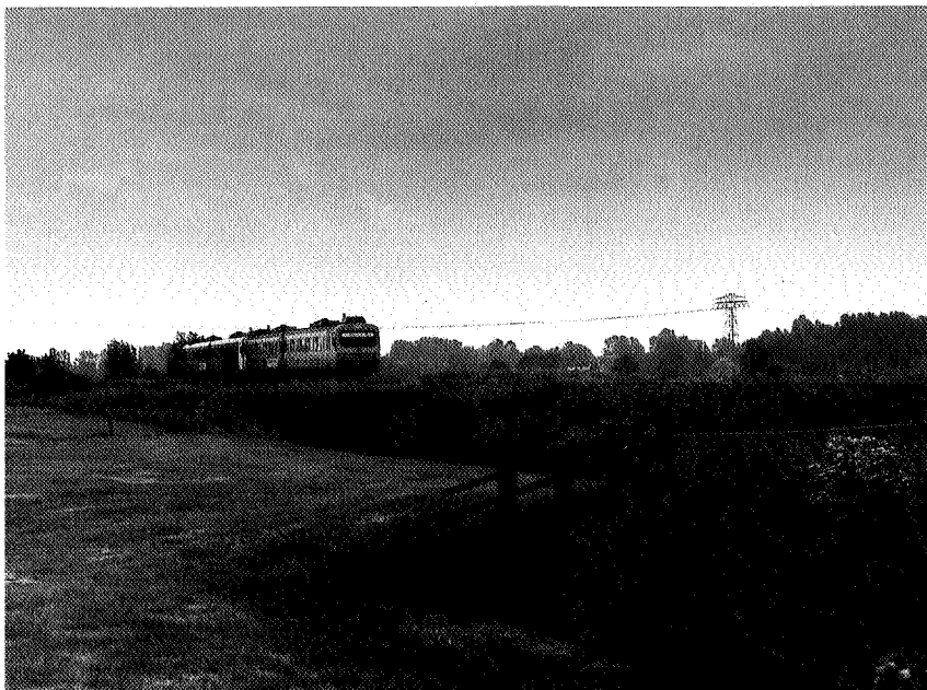
Spoordijk in de Koningslaagte wordt zodanig verhoogd dat een blik op het Reitdiepgebied niet meer mogelijk is. foto John Stoel
