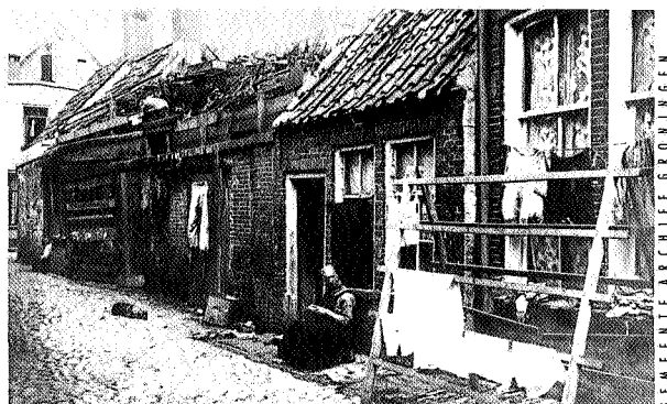
Vervallen woningen in de Moeskergang te Groningen rond 1914
