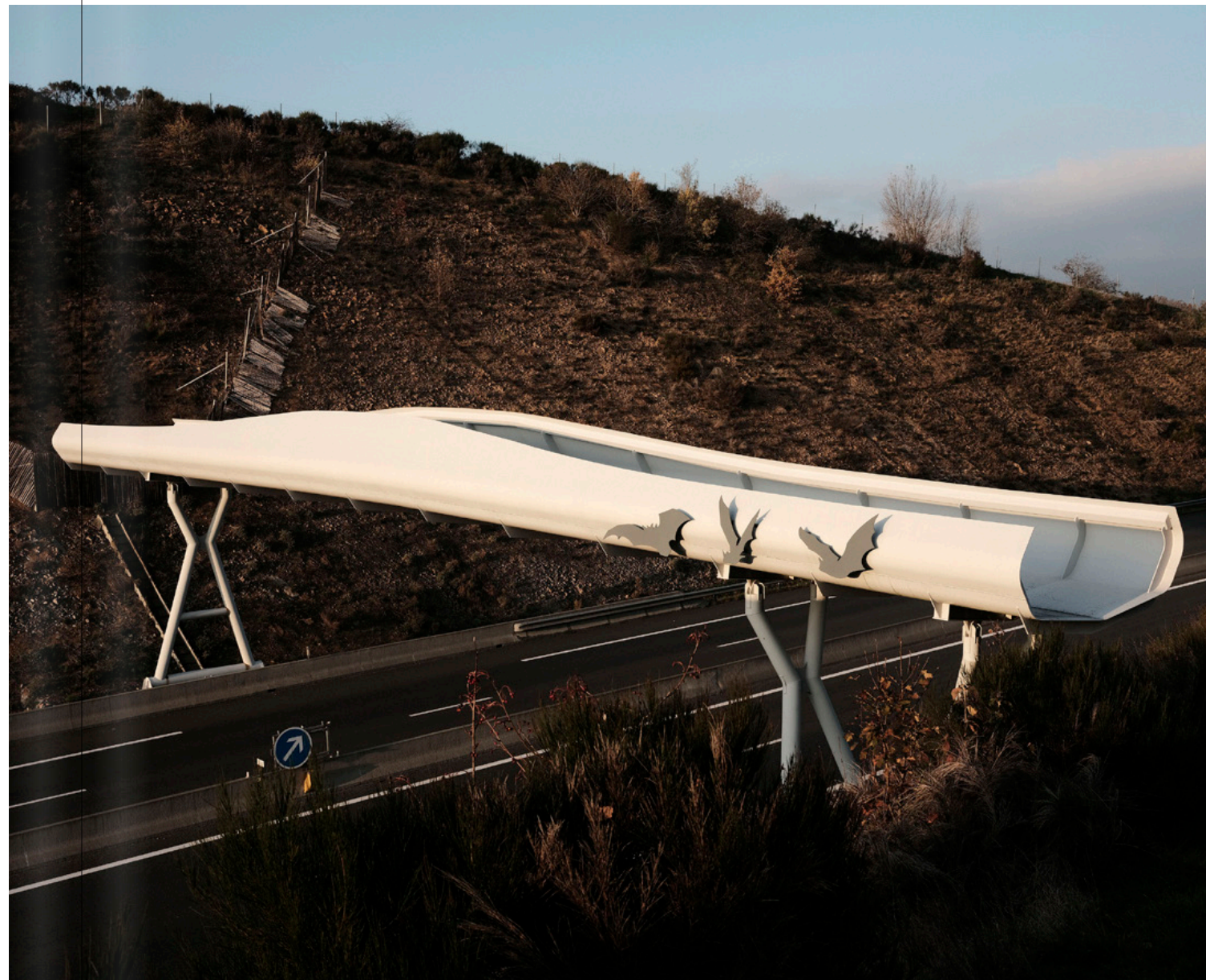
Deze vleermuisbrug moet de impact van wegen verminderen zodat vleermuizen veilig kunnen oversteken, al blijkt uit onderzoek dat ze niet erg effectief zijn. Neronde, Frankrijk.
