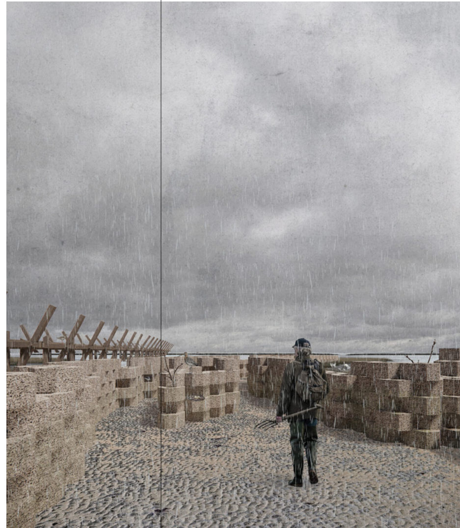
De sedimentvanger bestaat uit gestapelde schelpenblokken die sediment vasthouden. Dit creëert plek voor zoutminnende planten.
